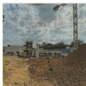
Le chantier a déjà démarré.
