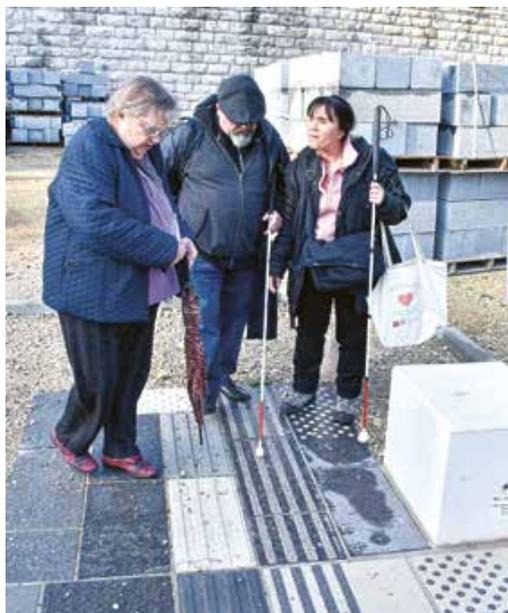
portes de la gare (après lesquelles les bandes de guidages intérieures prennent le relai), l'axe de la porte d'entrée des bus (chaque abribus intègre cet impératif), et jusqu'aux escaliers et ascenseurs de la passerelle. A ce niveau, les bandes de guidage seront relayées par des mains-courantes et des clous podotactiles sur les marches...
